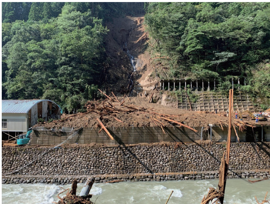
最も被害が大きかった椎葉村下福良の現場
